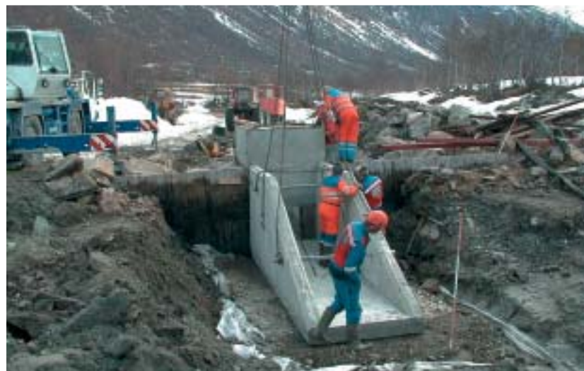
Montering av nytt tappearrangement for minstevannsføring Dalsvatnet. Foto: Harald Forodden.
