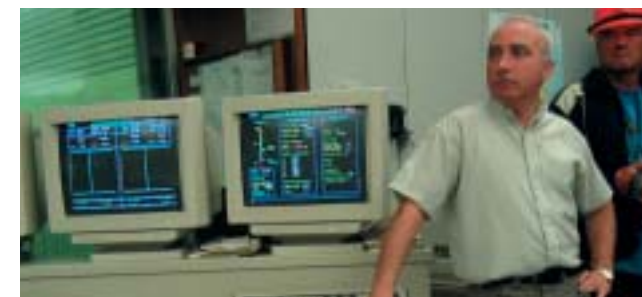
Fra kontrollrommet ved Turlough Hill Pump Storage Station.
