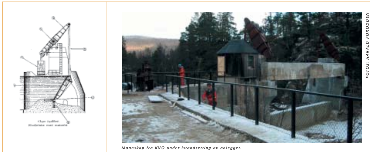
Mannskap fra KVO under istandsetting av anlegget.
