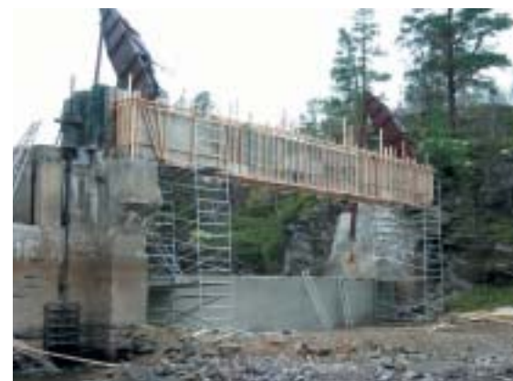
Restaurering av lukeanlegget og inntakskonstruksjonen.
