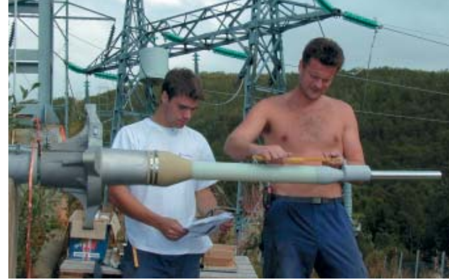
I sommer var tre av våre montører utleid til ABB, et oppdrag som gikk over åtte uker. ABB hadde entreprenøroppdrag for Statnett i Kandstadbotn transformatorstasjon utenfor Harstad. Her er Geir Sætre og Ole Sølberg i ferd med å klargjøre en 145 kV endemuffe.
