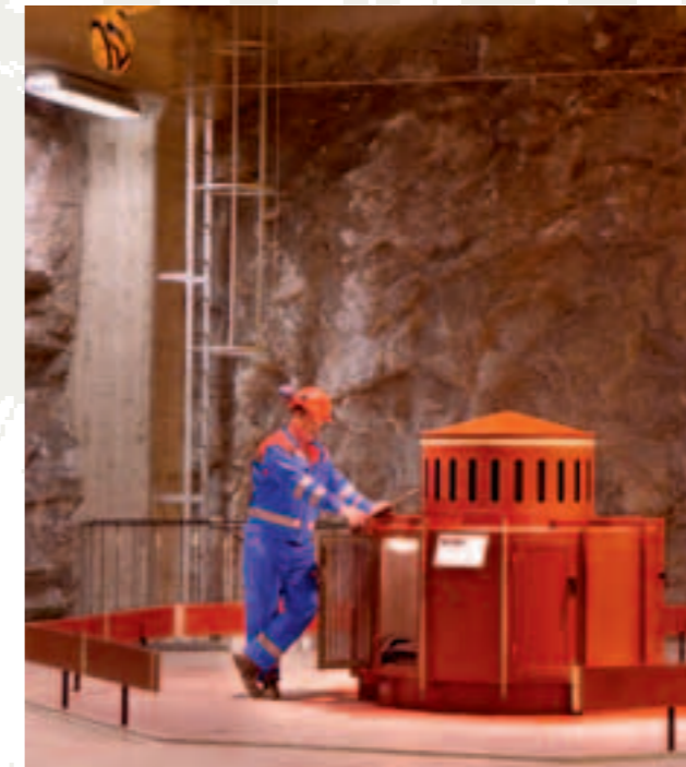
Morten Lillemo under inspeksjon i Mørre kraftverk på Fosen.
