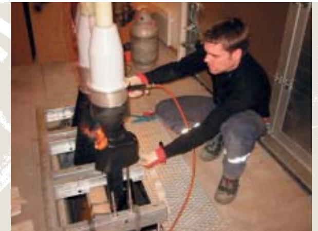
Geir Sætre i full gang med montasje av GIS-endeavslutning
