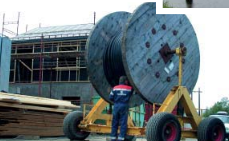
Bildet er tatt under kabeltrekking ved Myrhaugen transformatorstasjon. Kabelen er av typen TXLE 630 mm 145 kV. Foto: Knut Aalberg
