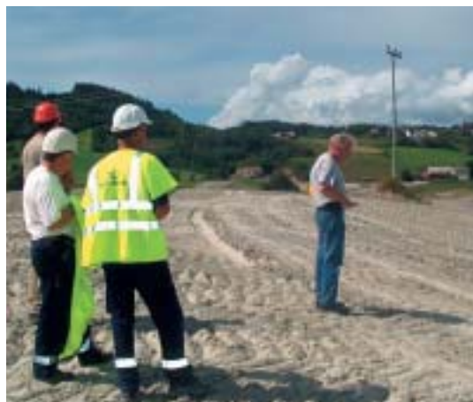
Anleggsarbeid i Børja.
