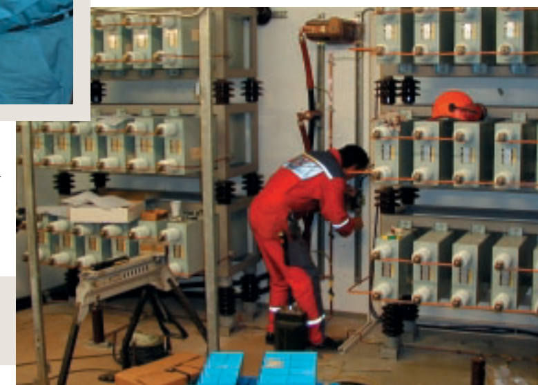
Nederst: Jarle Woldseth under montering av det nye kondensatorbatteriet inne i stasjonen. Foto: Steve Halsstrømning.
