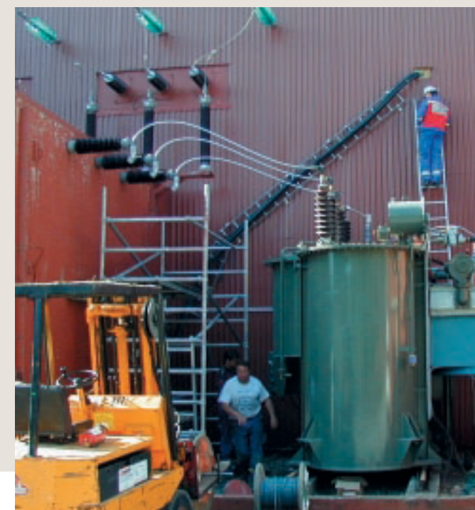
Montasje av ny trafo og kondensatorbatteri ved Sagberget trafo, mai i år. Øverst: Petter Engen og Asbjørn Sæter ved transformatoren som kom fra Evjen trafo.
