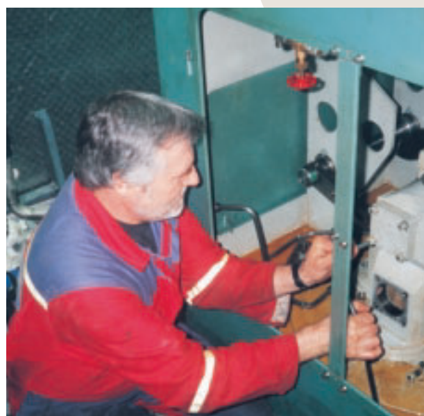
Leif Magne Resell under arbeid med skifte av deler i forbindelse med turbinregulator revisjon i mai, Litjefossen kraftstasjon. Foto: Jan Asphaug.
