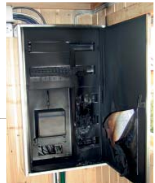
Lynnedslag i sikringskap. Det så bokstavelig svart ut etter at lynet slo ned i Myrhaugen koblingsstasjon.
