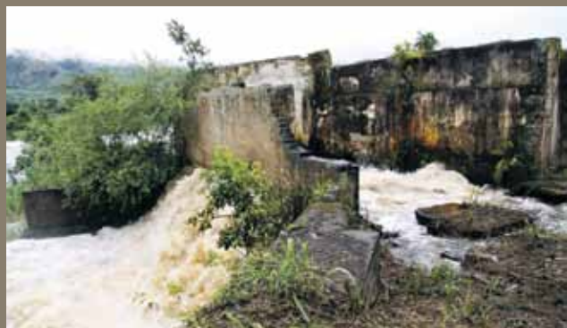
Ruiner av Kikagati kraftverk, som ble ødelagt under borgerkrigen i 70-åra. Som bildet viser er det stor vassføring, noe som vil bli utnyttet via rørturbiner i det nye kraftverket.
