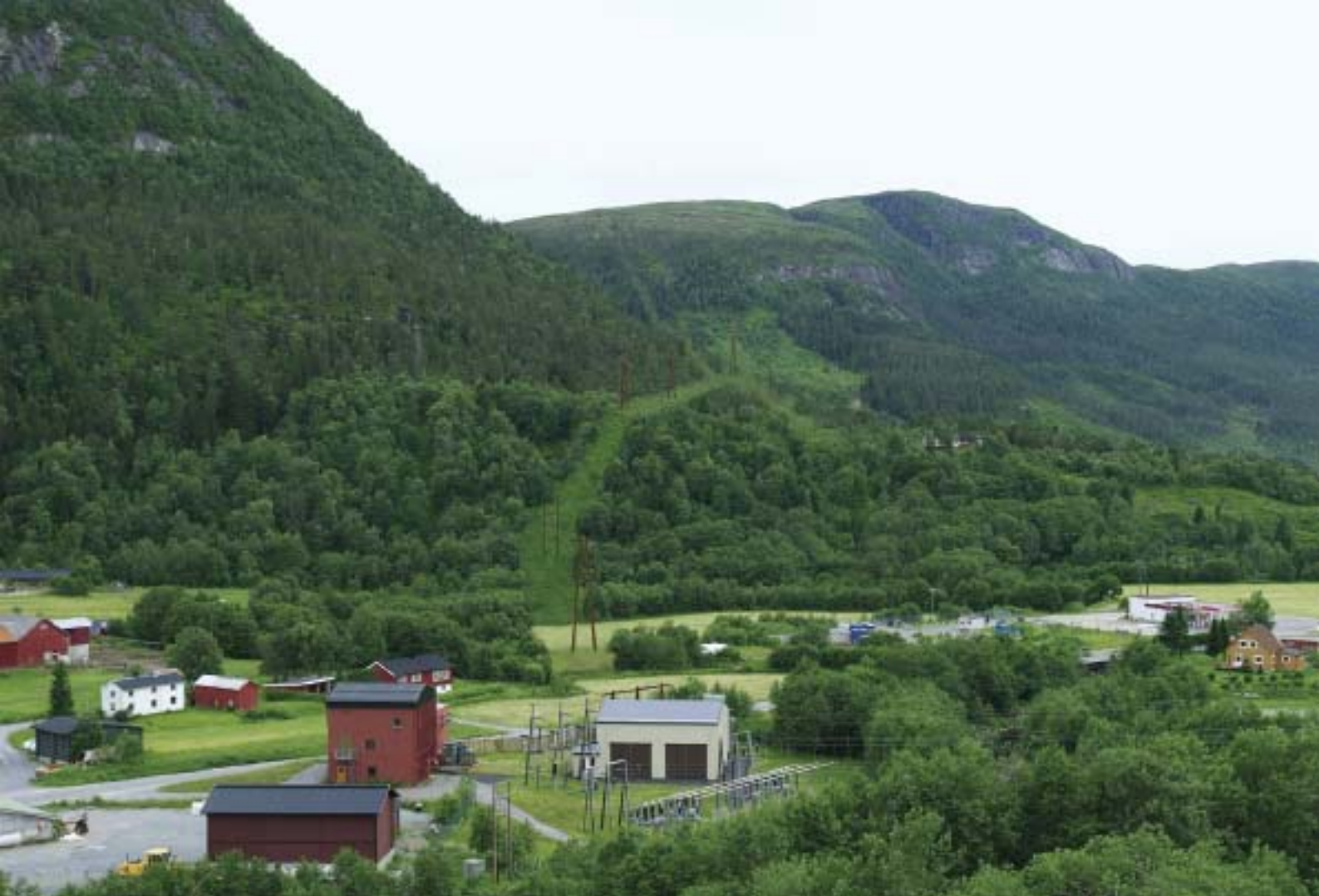
Snillfjord, kraftledning alt. 1 (som krysser Våvatnet)
